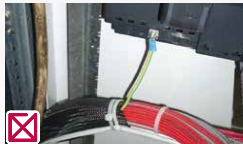
Uzemňovací kabel mechanicky namáhá bod připojení kvůli hmotnosti svazku: kabel nesmí být použit k zajištění svazku.
