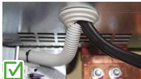
Kabelové průchodky se používají k ochraně kabelů při průchodem plechem.
