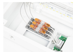
Vícepólové fixní zapojení svítidla
